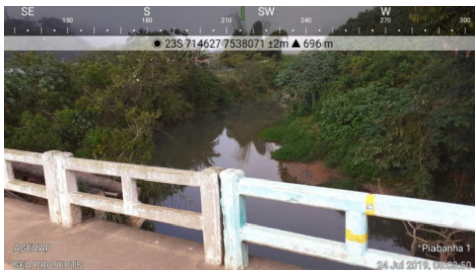
Figura 3.1-29: Visada para montante da estação controle – Ponto 9.
