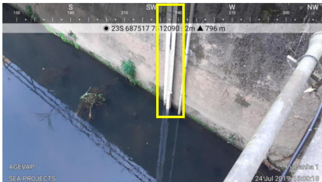
Figura 3.1-4: Régua de nível instalada no Ponto 1.
