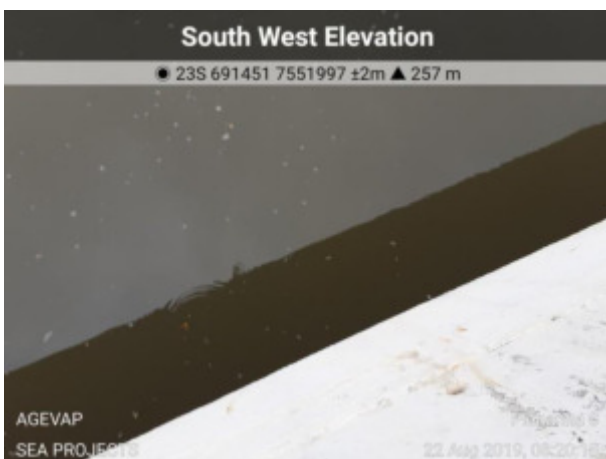
Ponto 8 – detalhe para espuma e flutuantes
