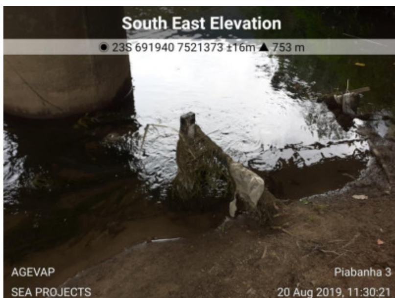
Figura 3.1-12: Régua de nível antes da limpeza.
