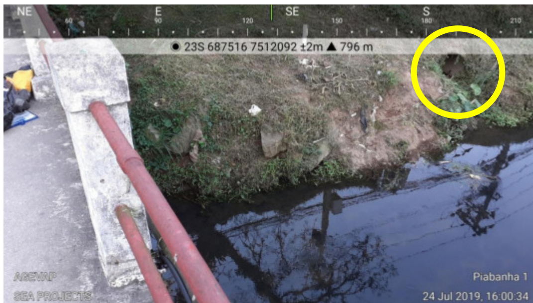
Figura 3.1-7: Tubulação na margem direita a montante do Ponto 1.
