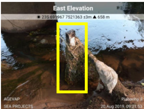
Ponto 3 – régua de nível antes da limpeza
